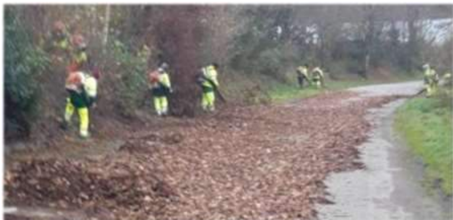
Activité voirie/soufflage de feuille à Cesson Sévigné
